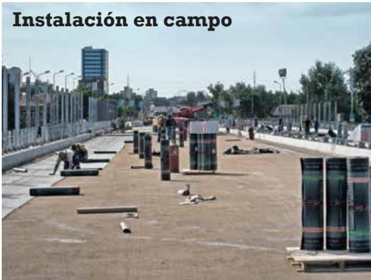
Membrana impermeabilizante para puentes POLYGLASS (tipo: POLYBOND HP, POLIFLEX HP, ELASTOFLEX HP, EVOLIGHT HP o POLIFLEX HP LIGHT -espesor sugerido: 5 mm.
