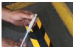
3. Inserte el tornillo en el tanquete plástico de expansión.
