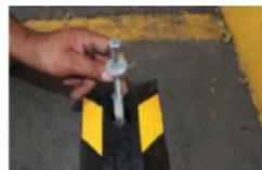
4. Inserte el tornillo con el tapete plástico de expansión y rondana dentro del orificio previamente hecho.
